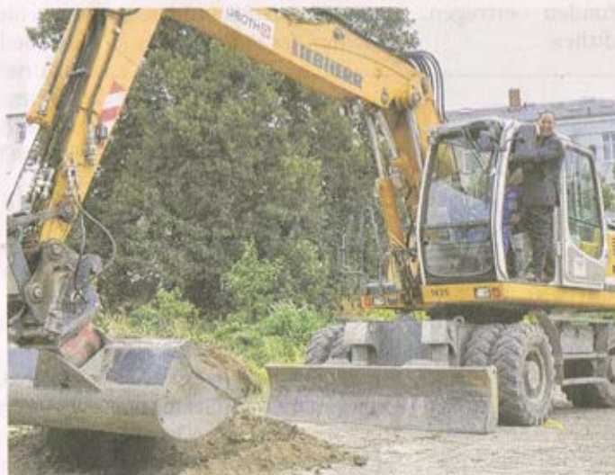
Der erste Spatenstich ist getan: Investor Dr. Oliver Spanehl setzt auf gehobenen Standard.
