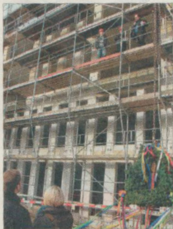
Auf der Baustelle für ein Zentrum am Vögenteich wurde Richtfest gefeiert.
